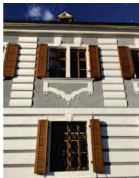
historisch, Fassade und Holzanstrich
